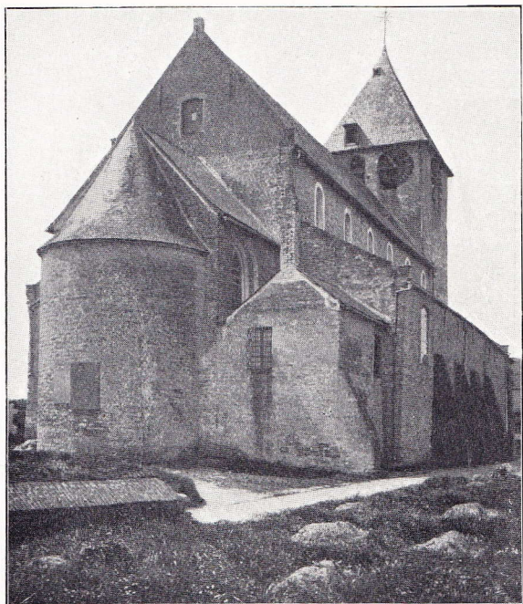
BERTHEM — L'église (côté septentrional)
